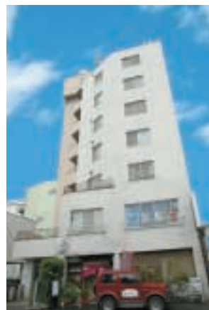
セントエルモ相武台
